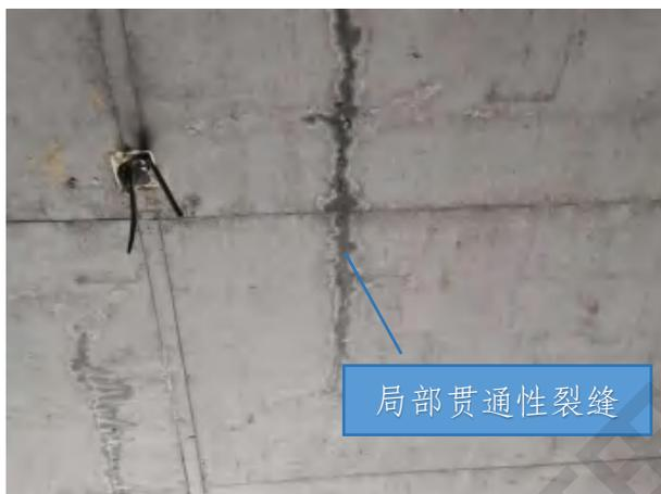
2.2 沿预埋管线裂缝：出现在板下表面居多，个别上下贯通。
